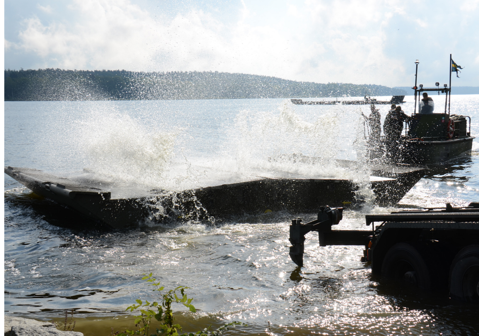
Pontonen plumsar ner i vattnet och vecklas samtidigt ut. Det är en av de första pusselbitarna till Däcksbros 200, som på en och en halv timme byggs ihop till sin fulla längd på 150 meter.
