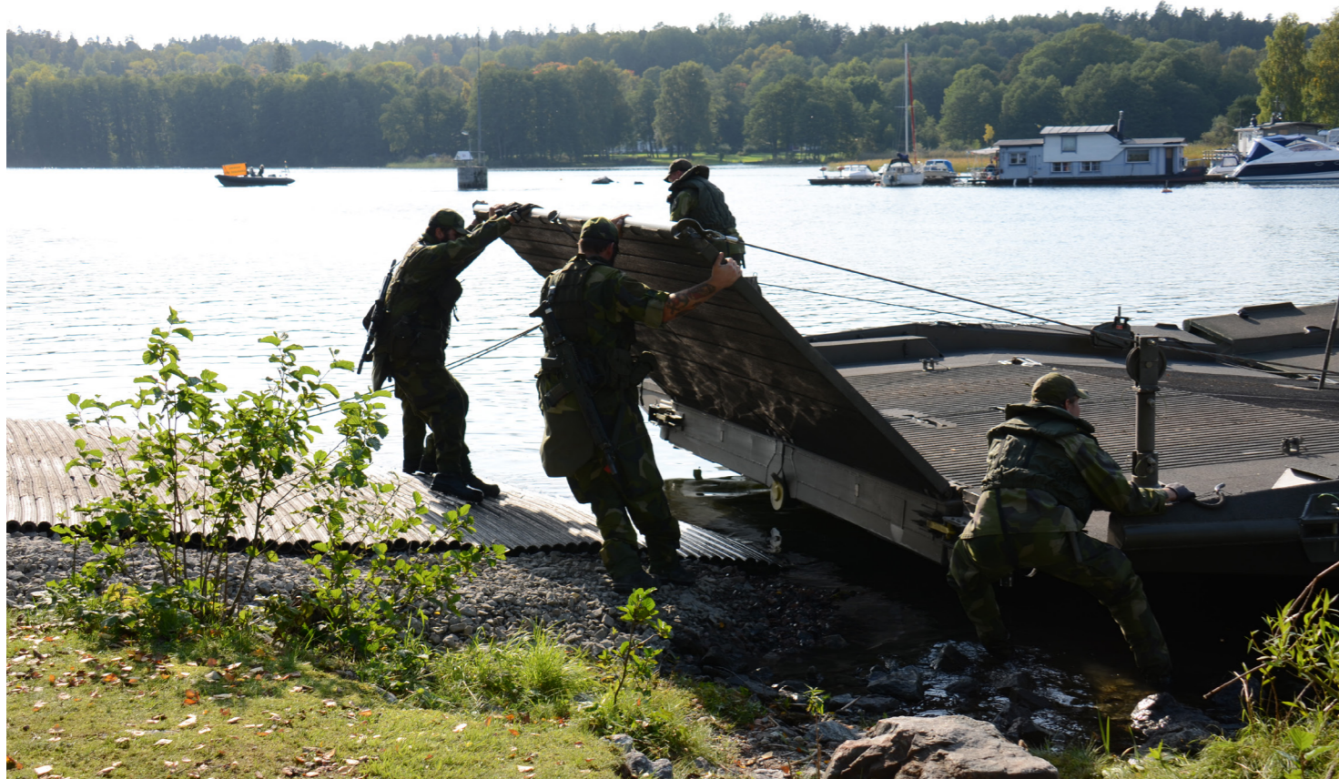
Ramp-pontonen förankras vid stranden så att ena änden av förbindelsen över vattendraget ligger fast.
